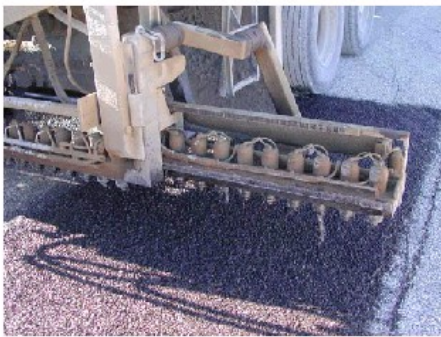
Foto N° 3 Camión y equipo extendedor
