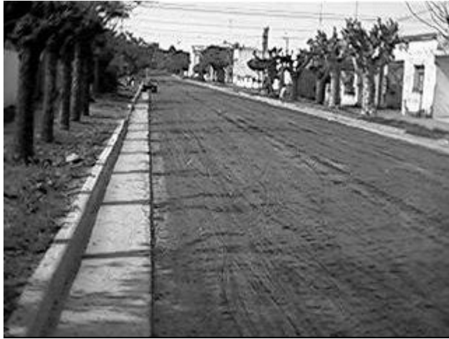
Fotografía 7. riego de imprimación
