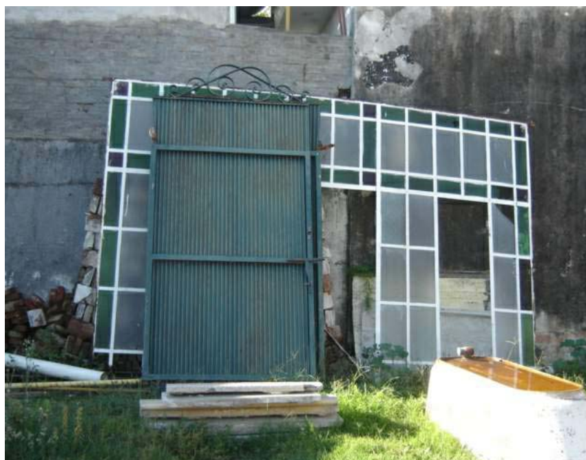
Figura 5: Aberturas y tirantería recuperadas de una obra demolida.
