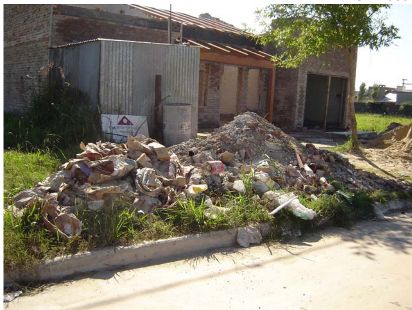
Figura 7: Residuos de construcción depositados en la vereda.
