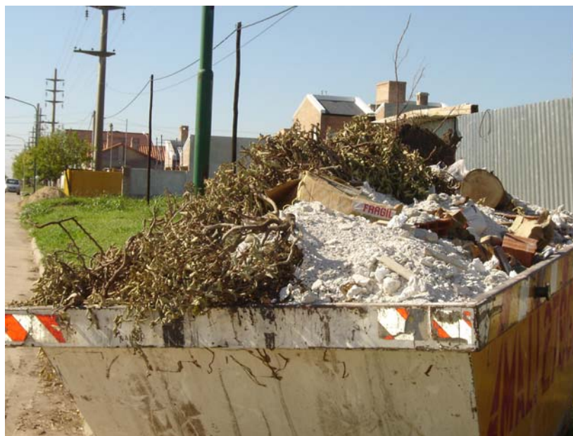
Figura 6: Contenedores correspondientes a obras en construcción con diversidad de residuos
