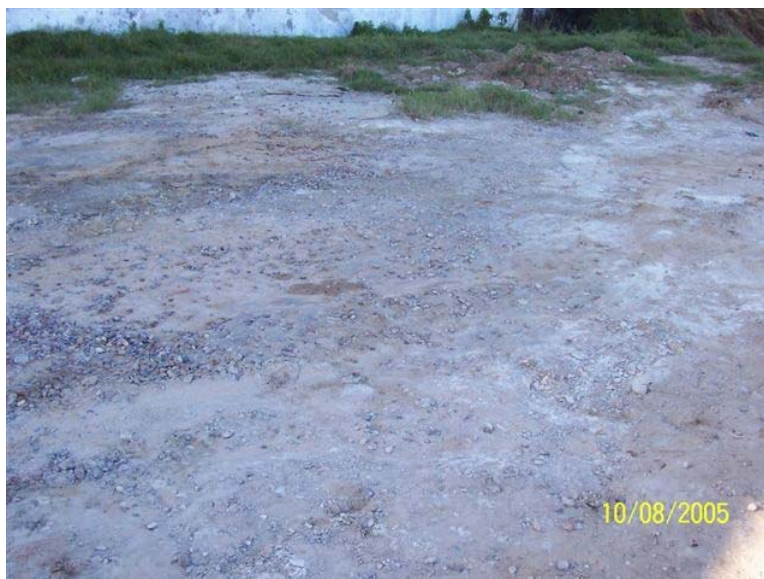
Residuos de hormigón reutilizados para sub-base.
