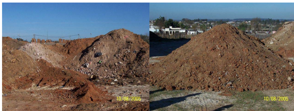
Áridos de demolición.
