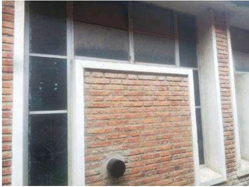
Imágenes de las aberturas existentes, vista exterior.
