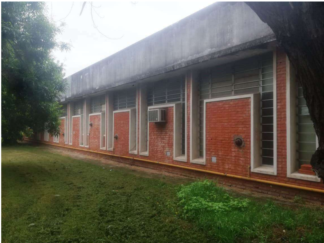
Imágenes de las aberturas existentes, vista exterior.
