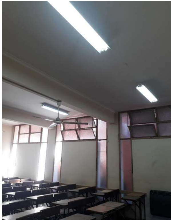
Imágenes de las aberturas existentes, vista interior.
