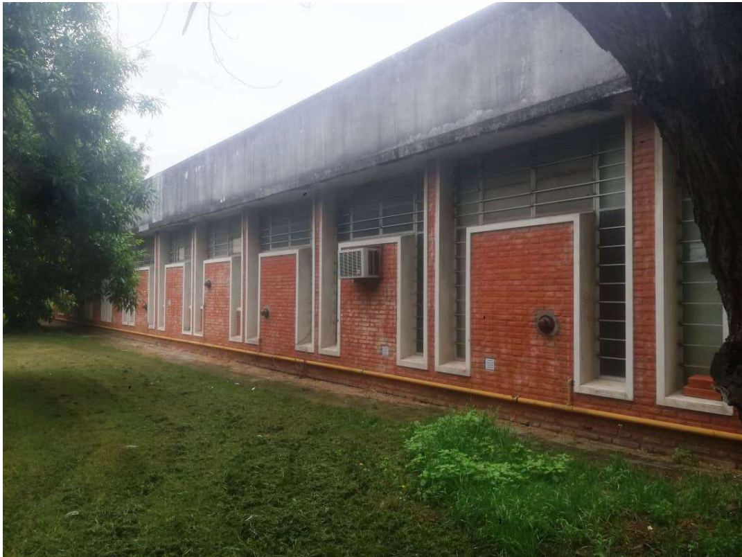
Imágenes de las aberturas existentes, vista exterior.
