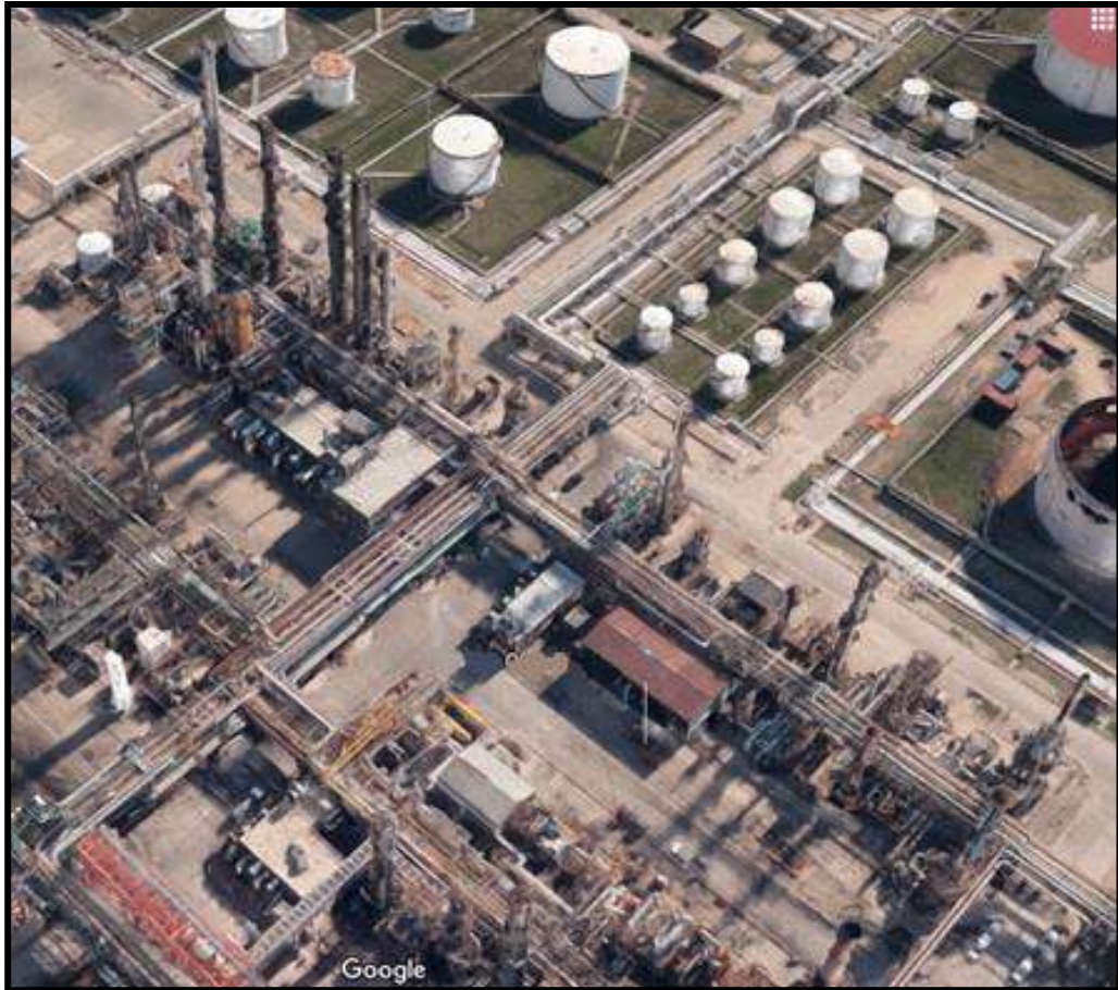
Fig. 6. Vista en perspectiva de instalación original
