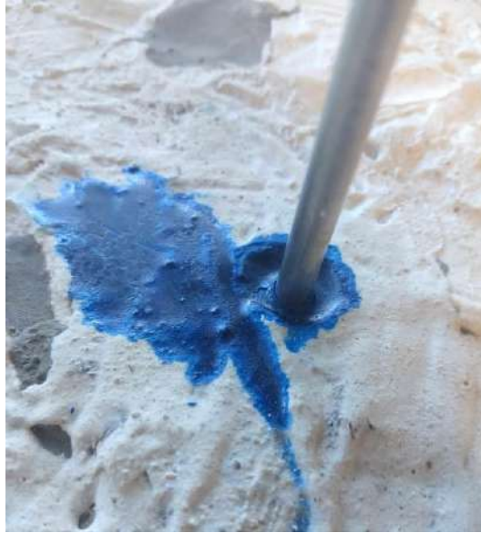
Fig. 6. Tapón de resina en la entrada del caño de un bloque de yeso.
