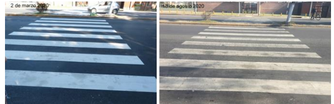
Figura 11. Senda peatonal carriles con sentido de La Plata a Berisso con pintura M1. Fuente: elaboración propia.
