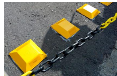
Imagen 11: Vista de las piezas al momento de la colocación
