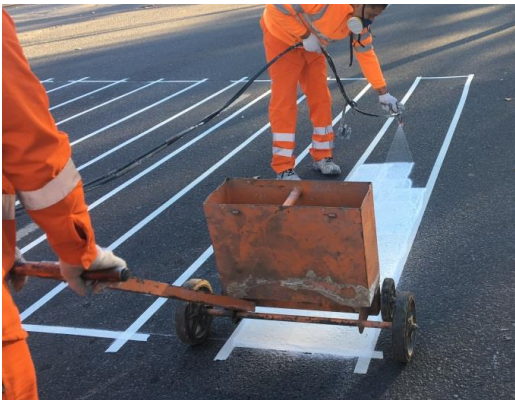
Figura 1. Aplicación de pintura sobre la senda peatonal.
