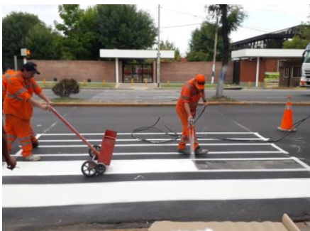
Figura 2. Aplicación de pintura sobre la senda peatonal.
