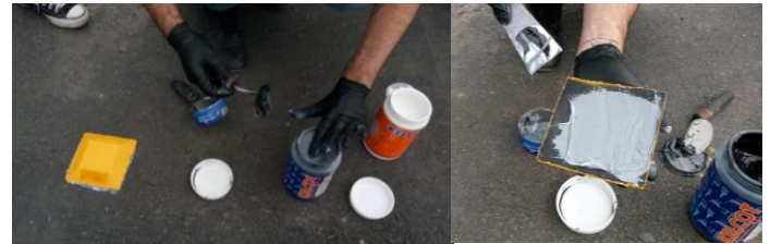
Imagen 10: Pegamento de las tachas en pavimento
