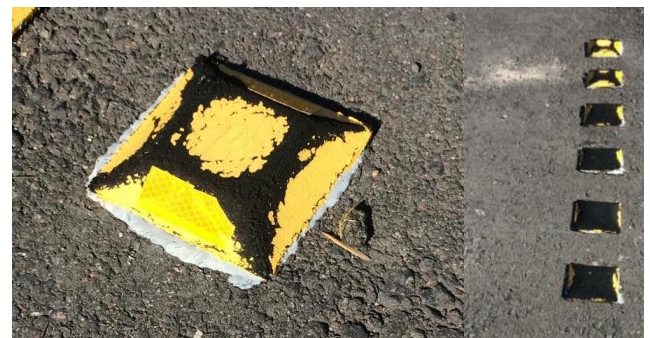
Imagen 12: Vista de las tachas después de 6 meses de su colocación
