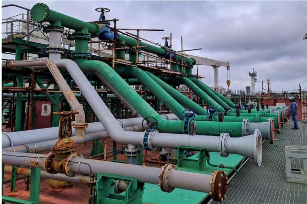
*Figura 1: Manifold montado sobre la C.79 (buque productero).*
