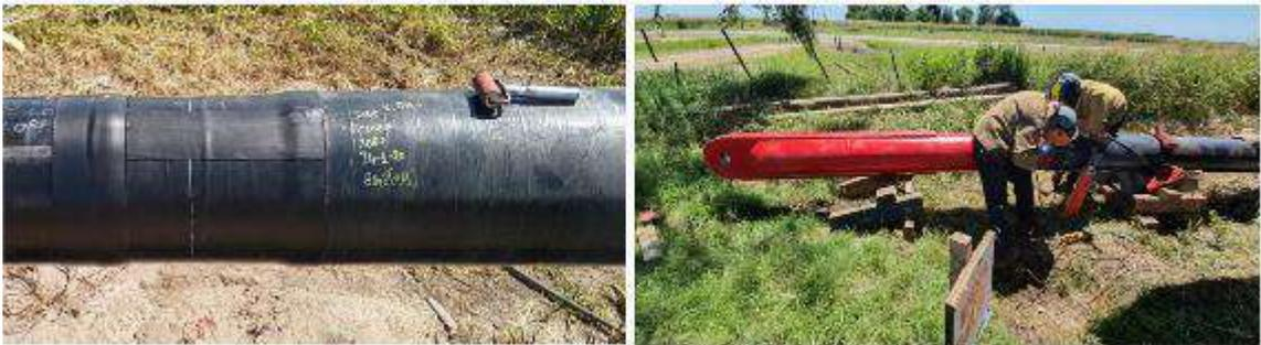
Fig. 9 Revestimiento uniones soldadas – Construcción Cabezal de tiro
