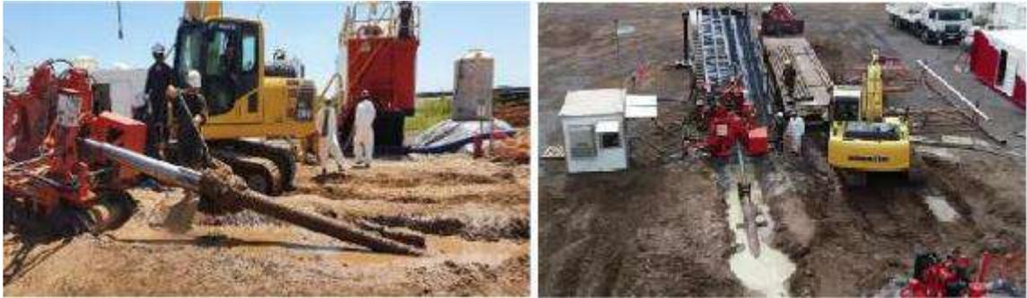
Fig. 12 Perforación piloto
