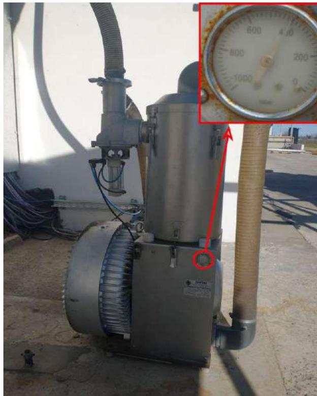
*Figura 4 - Presión a la entrada de la turbina*
