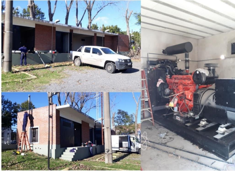
Trabajo de puesta en marcha del grupo electrógeno
