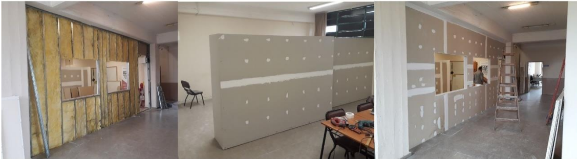
Imágenes de los trabajos de tabiquería.
